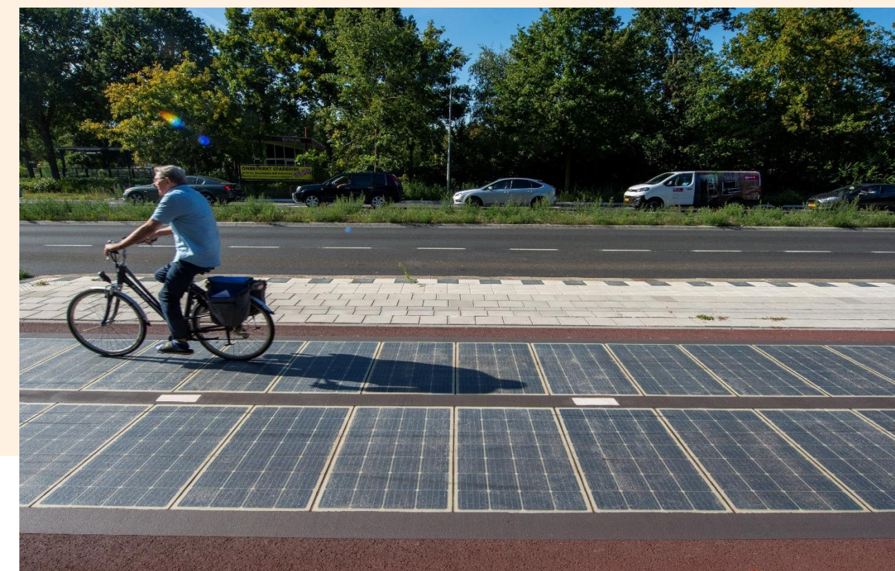
Centrale photovoltaïque circulaire intégrée sur une piste cyclable – 3 kWc – Grave, Pays Bas
