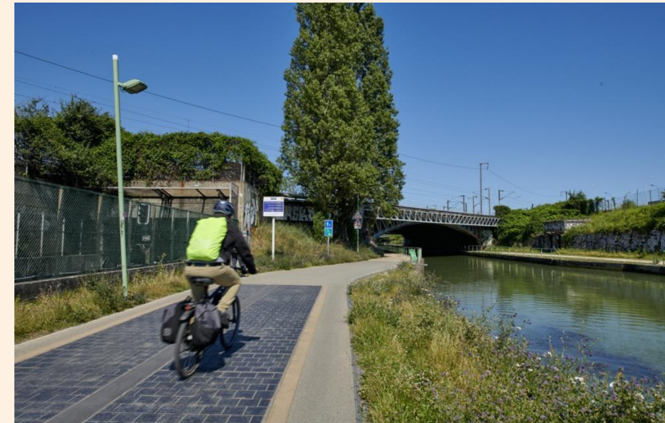
Centrale photovoltaïque circulaire intégrée sur une piste cyclable – 6,5 kWc – Bobigny, France
